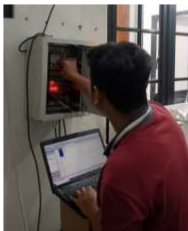
Gambar 9 Integrasi Sistem ATS dan Panel Surya
