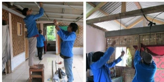
Gambar 1. Mahasiswa memperagakan cara instalasi kabel ke lampu
