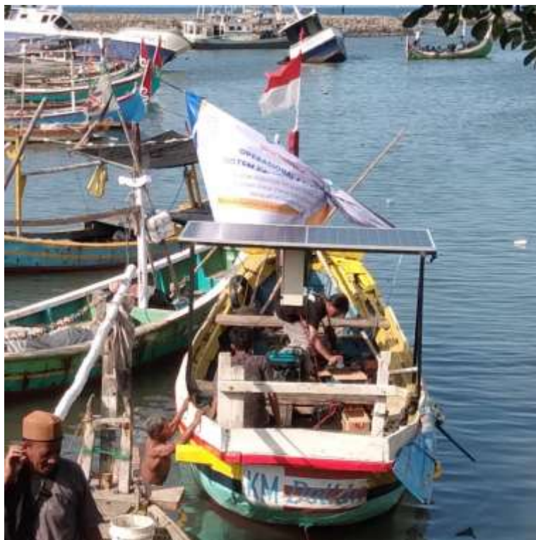
Gambar 3. Pemasangan peralatan monitoring kebocoran
