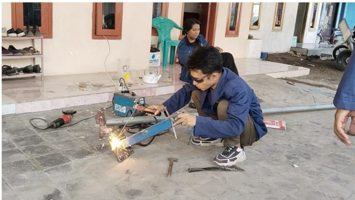
Gambar 5. Proses pengelasan pembuatan tiang penerangan
